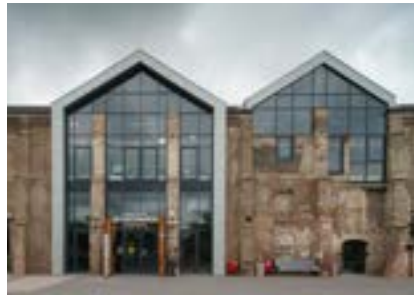
Greswarenfabrik Greswaren, Niederlande Segment: Büro
