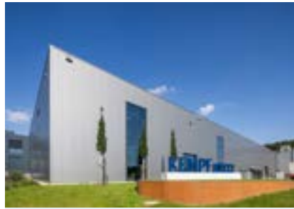
Kempf GmbH Rohrbach, Deutschland Segment: Büro
